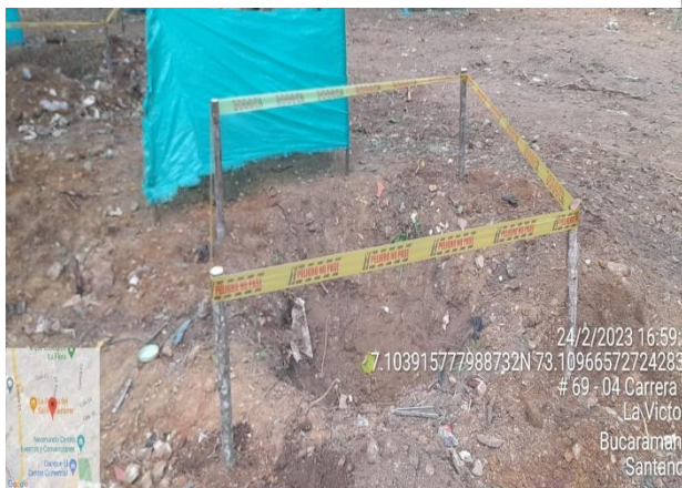
Sondeos para verificación de material existente
