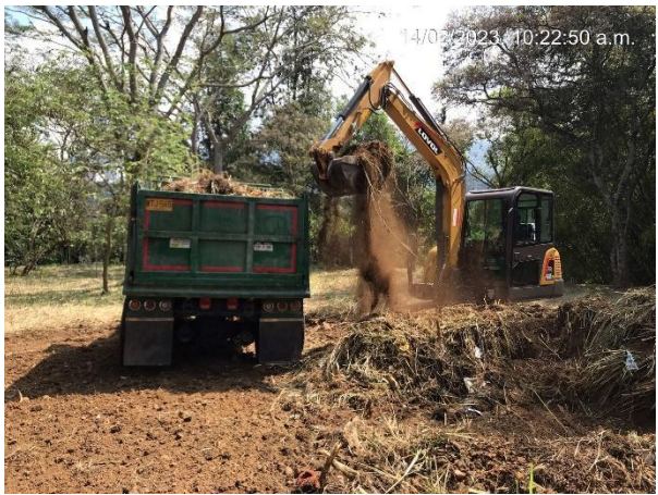
ITEM1.4.4: Descapote manual, incluye cargue, retiro y disposición final. ANTES DESPUES
