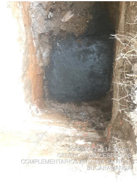
ITEM 2.1.1: Solado de limpieza en concreto 1500 psi mezclado en sitio
