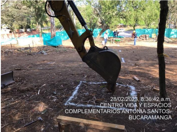
ITEM 1.4.3: Excavación mecánica en material común, incluye cargue, retiro y disposición final
