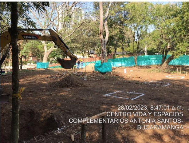
ITEM 1.4.3: Excavación mecánica en material común, incluye cargue, retiro y disposición final
